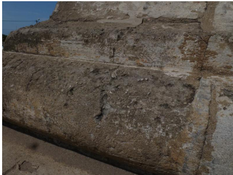
Figure 2 Phare : base en briques de ciment moulé et moulure moulée
