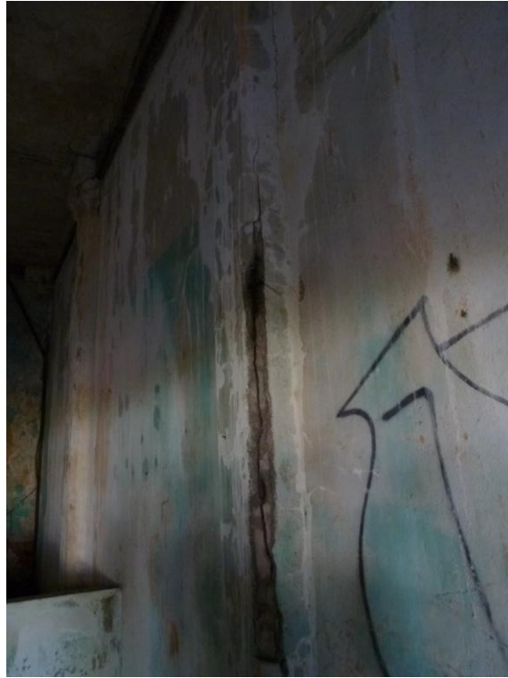
Figure 16 Pile intérieure en béton armé
