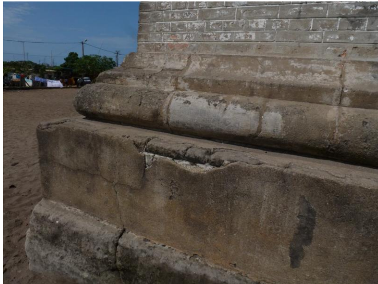
Figure 1 Phare : base en briques de ciment moulé et moulure moulée
