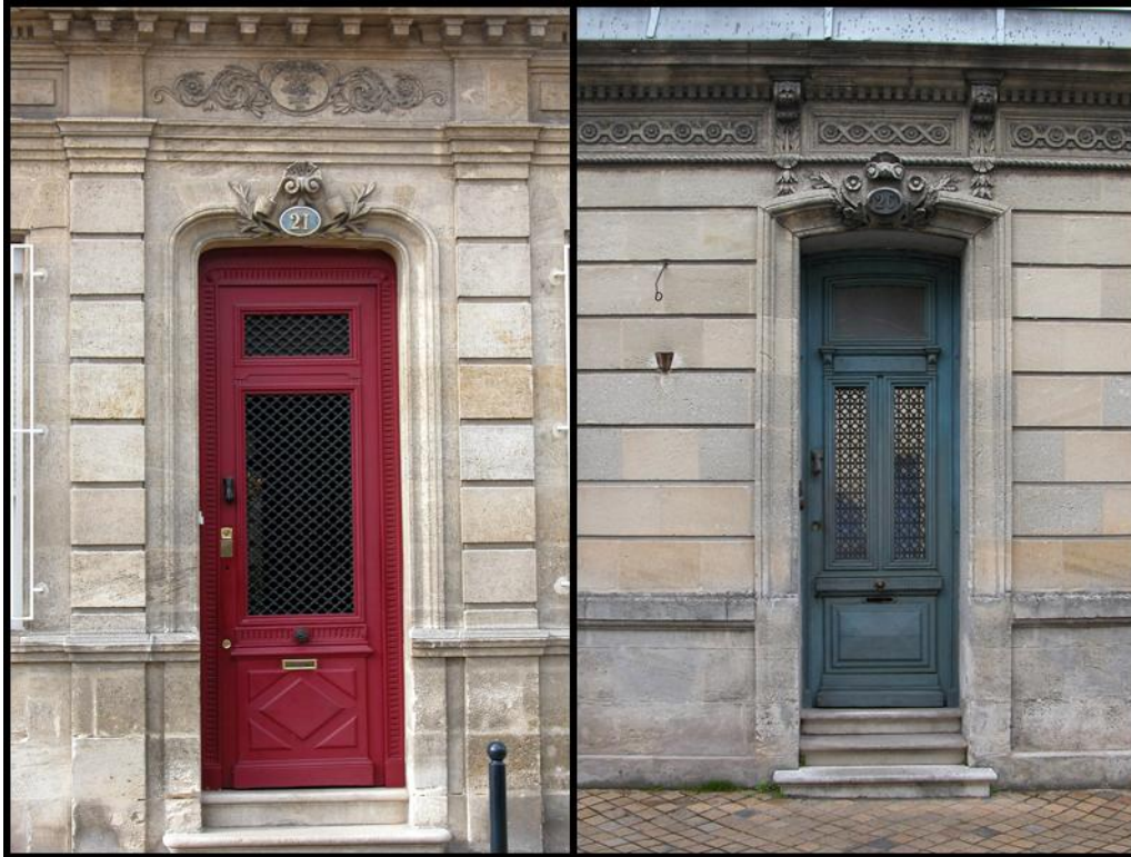
Figure 15 : Portes des maisons bordelaises, grille, panneau vitré et panneau bois. (Source : A.-L. Moniot)
