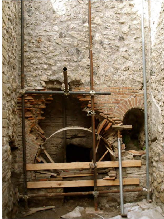
14 - Casa di Siricus (VII, 1, 25-47), chantier de restauration du four à pain.
