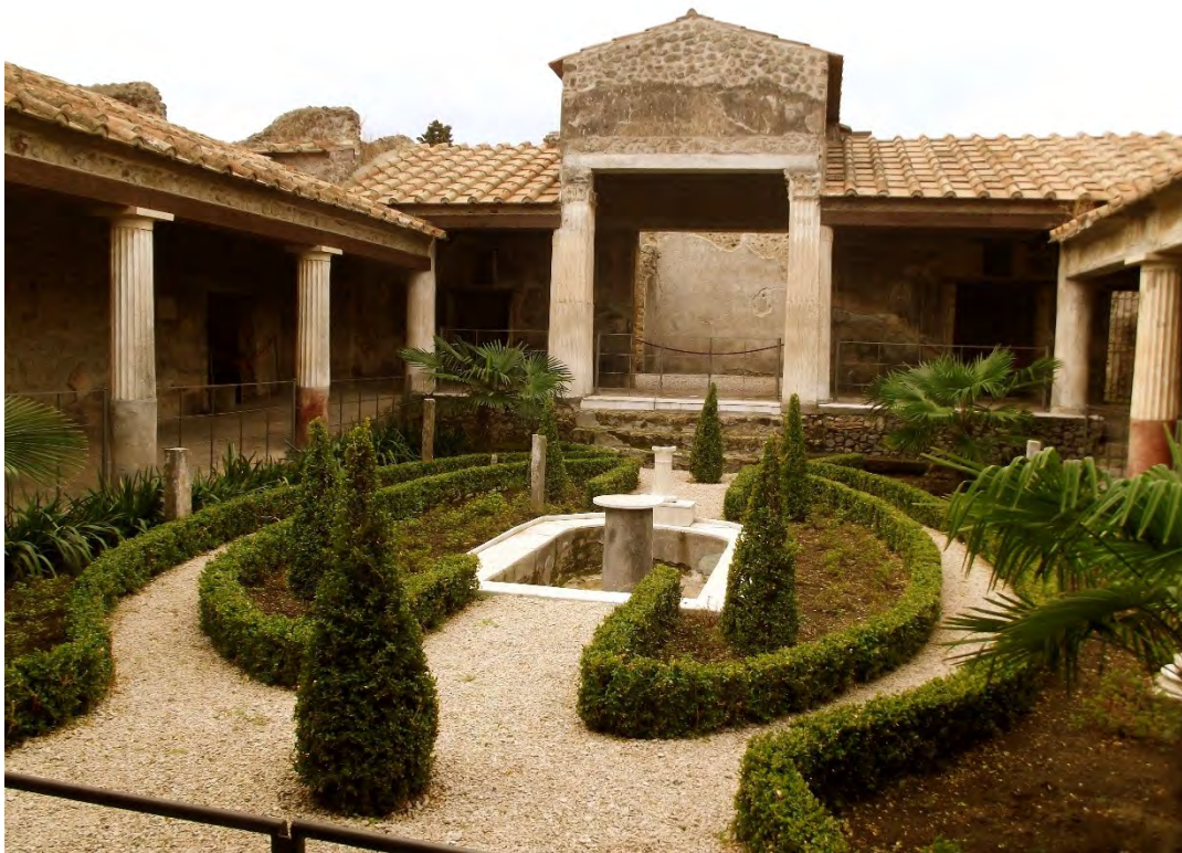
21 – Casa degli Amorini Dorati (VI, 16, 7), très bon exemple de restauration achevée en 2014.
