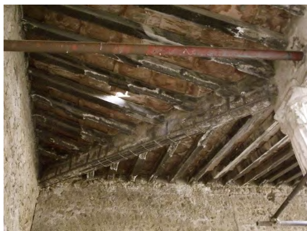
16 – Casa di Trebius Valens (III, 2, 1), Pergola du triclinium estival placé sur étais. Le chantier de restauration avait été achevé en 2013, sans que fut dégagé l'arrière du mur de fond recevant la poussée des terres.
