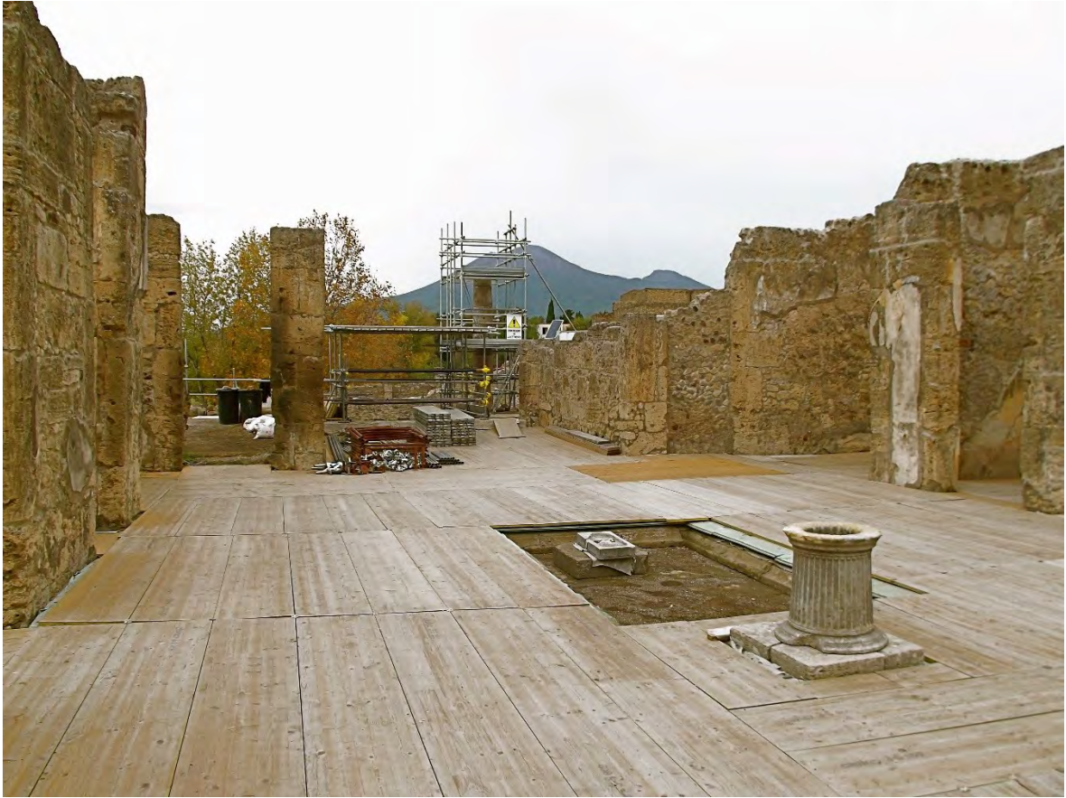
27 – Casa del Marinaio (VII, 15, 2), Chantier de restauration en cours, protection totale des sols.
