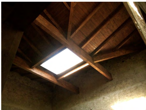
16 – Casa di Trebius Valens (III, 2, 1), Pergola du triclinium estival placé sur étais. Le chantier de restauration avait été achevé en 2013, sans que fut dégagé l'arrière du mur de fond recevant la poussée des terres.
