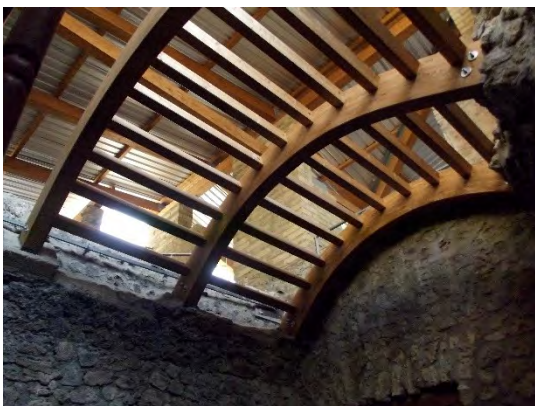
25 – Casa del Criptoportico (I, 6, 2), évocation brutale d'une voûte ; les éléments subsistants autorisaient une restauration à l'identique, sans trahison de l'aspect originel.
