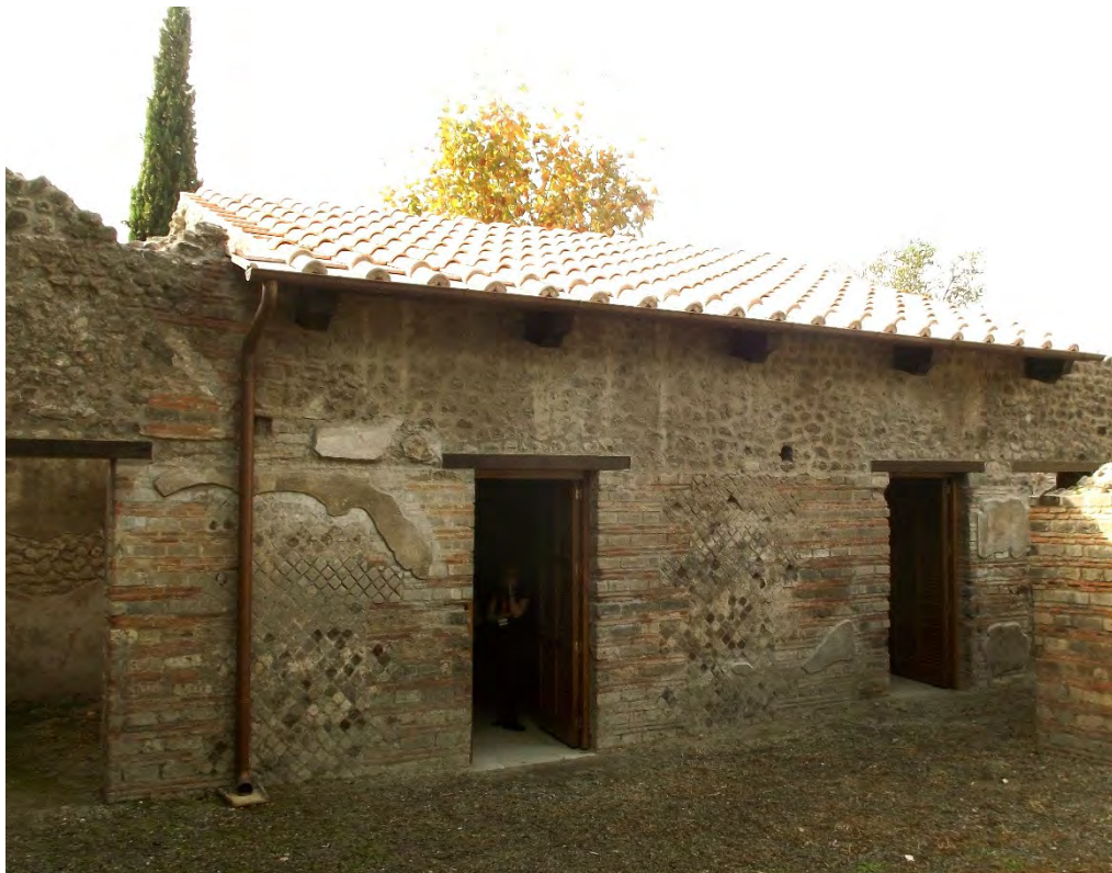
11 – Casa delle Pareti Rosse (VIII, 5, 37), Bon exemple de chantier de restauration de l'architecture.
