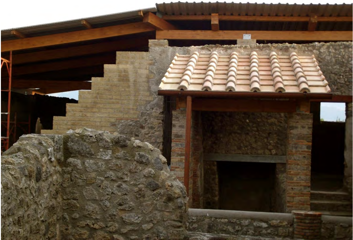
24 – Casa del Criptoportico (I, 6, 2), restauration achevée, avec des options trop contrastée, qui dénaturent l'édifice antique (maçonnerie, toitures).
