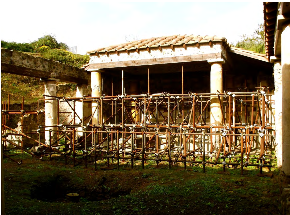
16 – Casa di Trebius Valens (III, 2, 1), Pergola du triclinium estival placé sur étais. Le chantier de restauration avait été achevé en 2013, sans que fut dégagé l'arrière du mur de fond recevant la poussée des terres.
