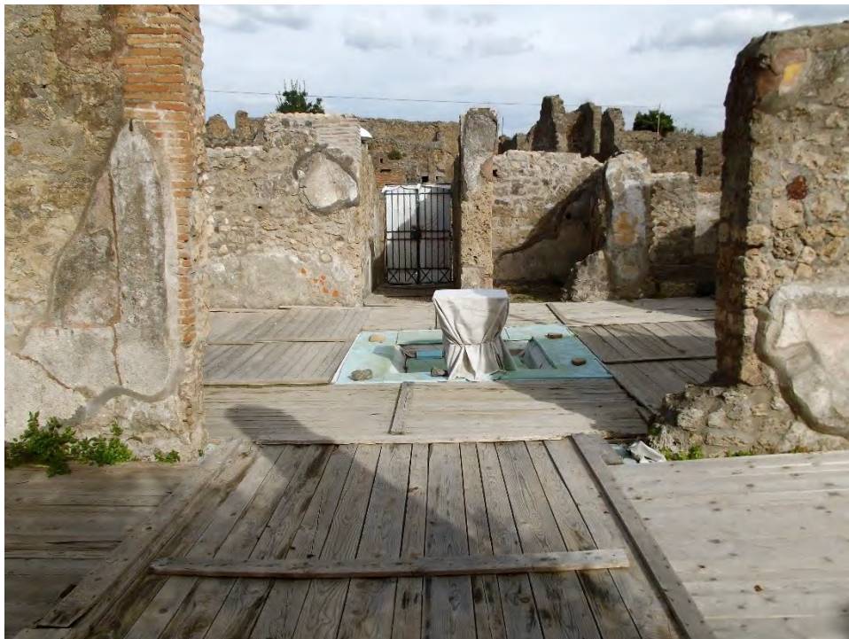
15 – Casa di Siricus (VII, 1, 25-47), chantier de restauration du second atrium avec protection des sols.
