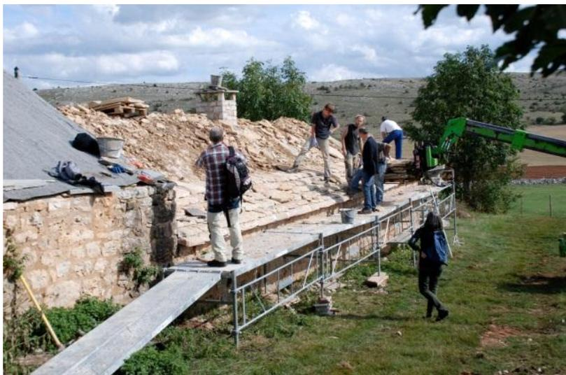
Rénovation d'un toit en lauzes de calcaire
