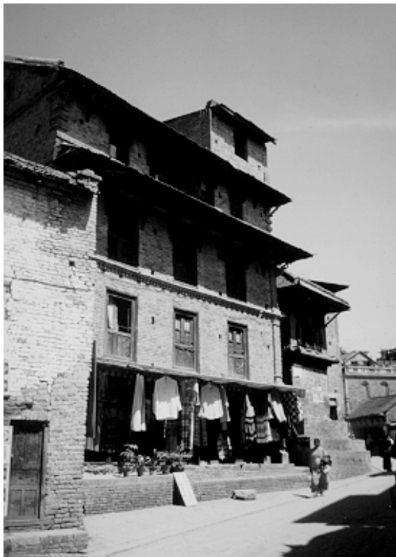
(Above) Original Rana period building in 1998 before demolition. (Ci-dessus) Bâtiment d'origine de la période Rana avant démolition en 1998.
