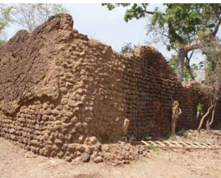
Figure 8 : Angle sud-est après stabilisation. © L. Simporé
