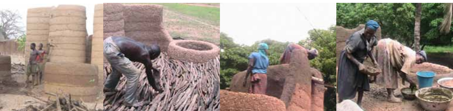
Figures 2, 3, 4 et 5 : Étapes de construction : dallage, crépissage et enduits lors de la mise en oeuvre du projet de réhabilitation des tatas. Projet financé par la Fondation Prince Claus des pays Bas en 2011. © A. B. Karka/Site Koutammakou
