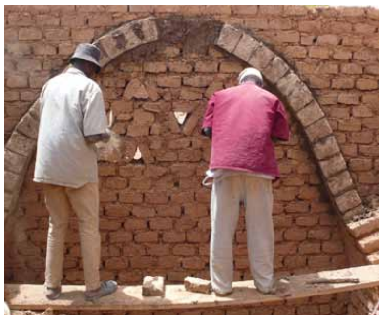
Figure 5 : Construction voûte MCB. © L. Cissé
