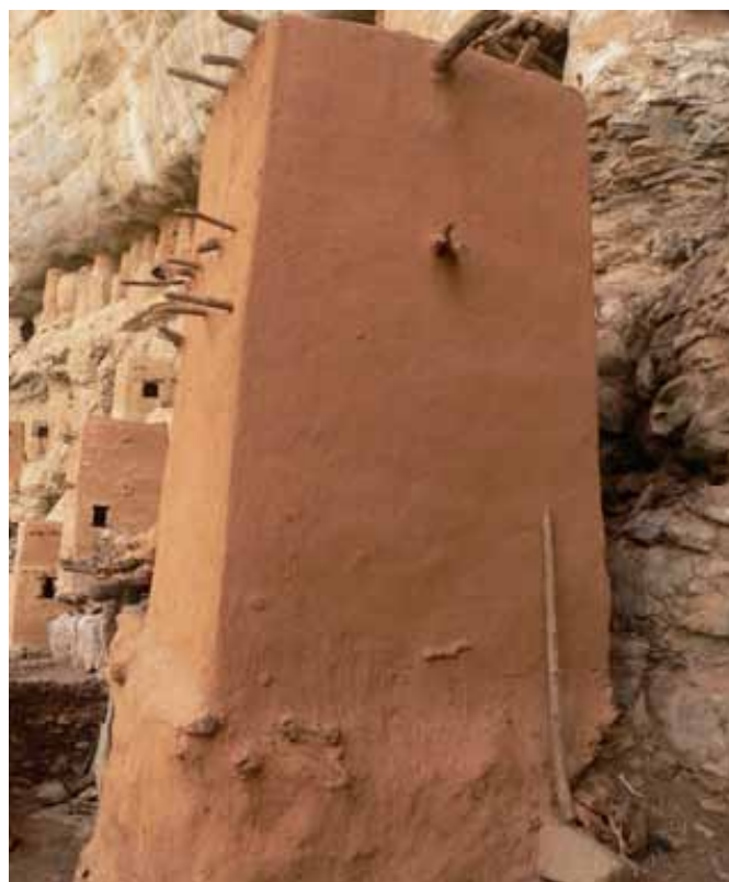
Figure 2 : Grenier tellem restauré, 2006. © L. Cissé
