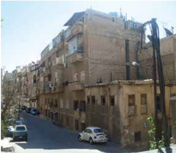
Photo 4 : Les deux générations de constructions du quartier al-Muhajirine. Au premier plan une construction en bois et en briques de terre crue ; derrière une barre de nouvelle génération de bâtiments : immeubles en béton armé. © A.Soufan
