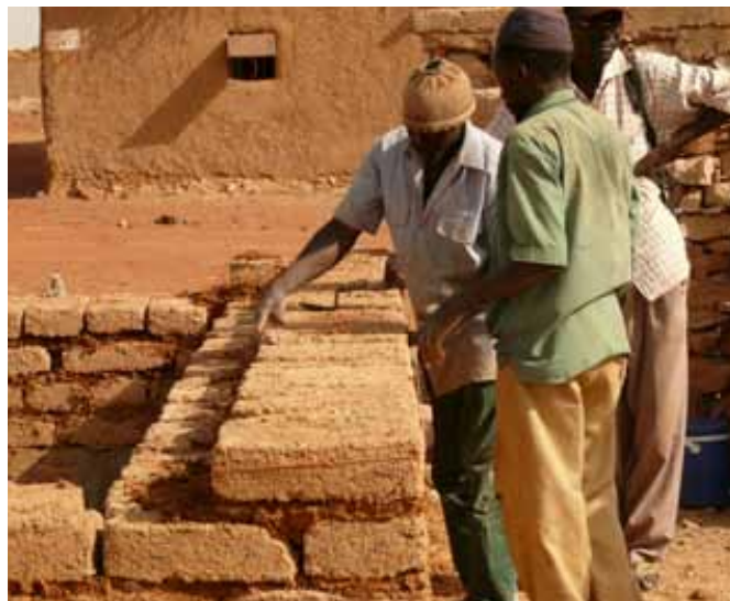
Figure 8 : Chantier-école MCB, 2008. © L. Cissé
