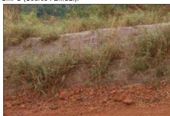
Photo 10 – Protection des bords de voie d'accès contre l'érosion par plantation et installation de géotextile, Concession SMFG (Source : EMC2I)
