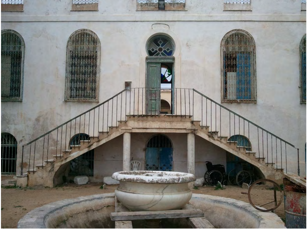
Le Borj Boukhris en cours de rénovation
