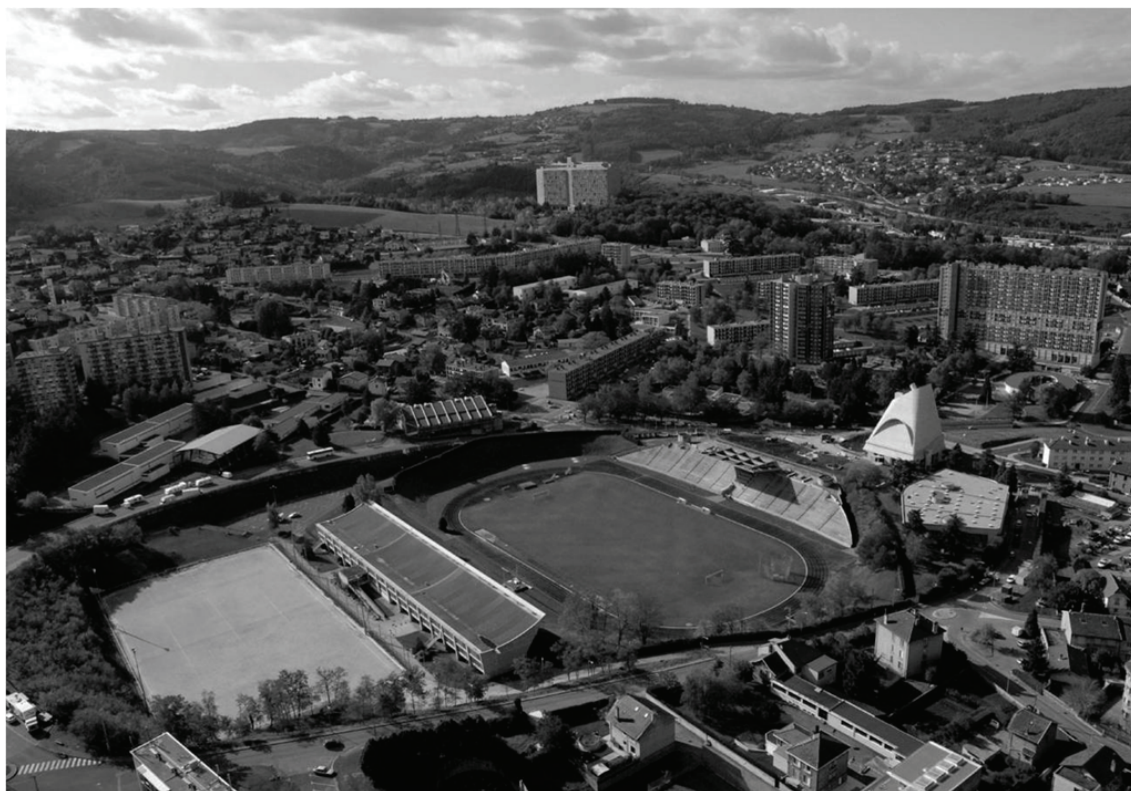
Firminy-Vert – vue aérienne du site, 2006 - France
