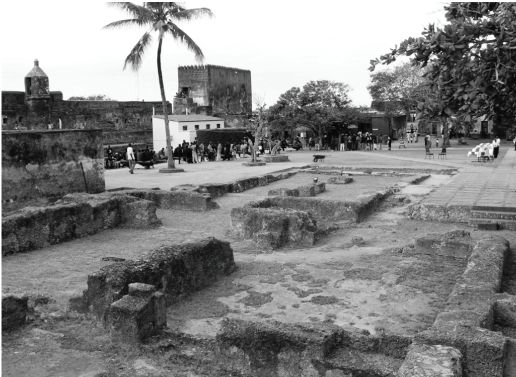
Vue de l'intérieur du fort
