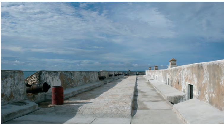
Remoção da vegetação intrusiva e reconstrução da superfície da laje.
