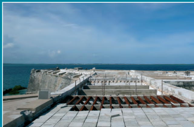
Reconstrução e impermeabilização das lajes de cobertura em pedra de coral.
