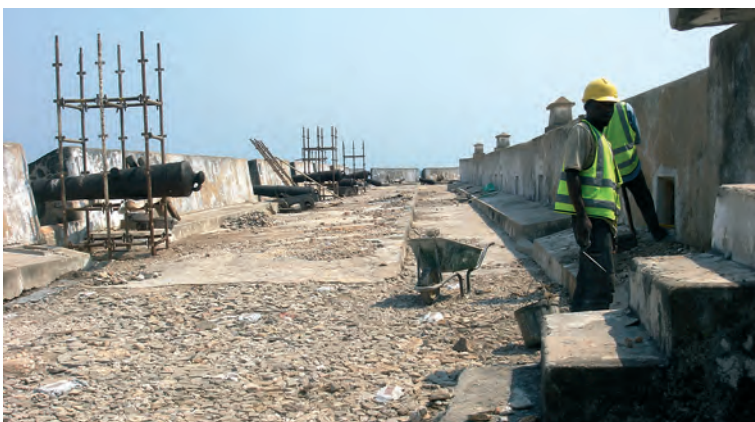
Remoção da vegetação intrusiva e reconstrução da superfície da laje.
