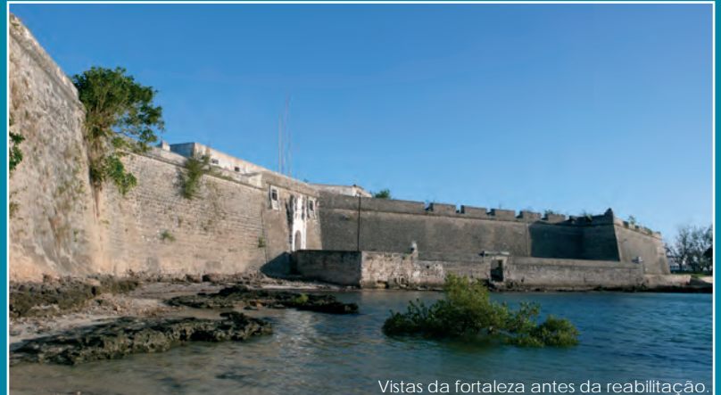
Vistas da fortaleza antes da reabilitação.
