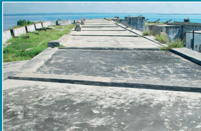
Reconstrução e impermeabilização das lajes de cobertura em pedra de coral.
