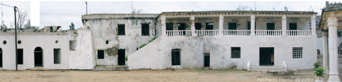
Fachada interior do pátio
