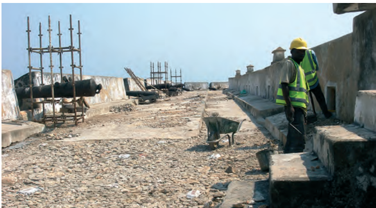
岩に根付いた植物の除去と、北東塁道の舗装修復の様子
