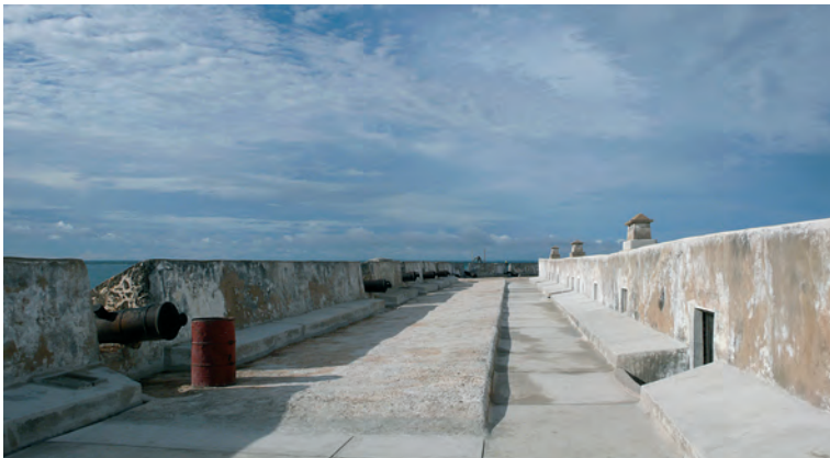
岩に根付いた植物の除去と、北東塁道の舗装修復の様子
