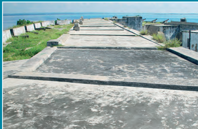
珊瑚石の屋根板で葺かれた屋根の再建と防水処理
