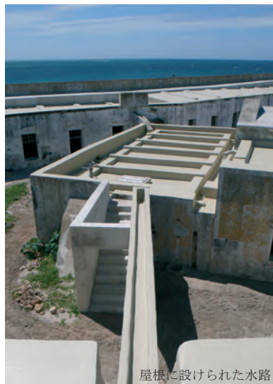
屋根に設けられた水路
