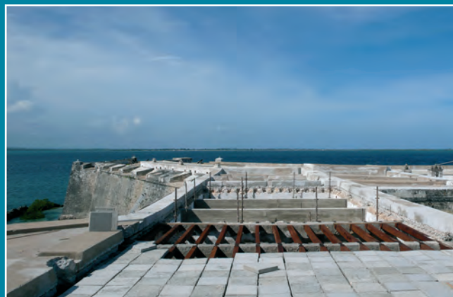
珊瑚石の屋根板で葺かれた屋根の再建と防水処理
