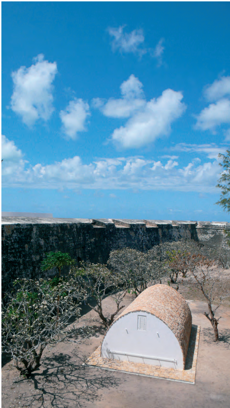
新たに砦の外に設置された貯水槽には、修復された砦の集水システムによって集められた水が貯えられており、モザンビーク島の住民たちに真水を供給しています。
