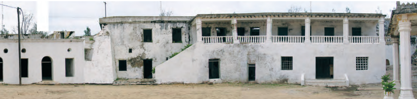
砦内部南面の外観
