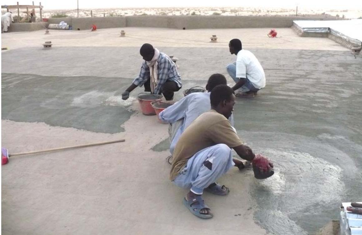
*Reconstruction de la toiture en diminuant l'épaisseur et en créant des pentes plus fortes avec une finition avec un dallage de briques d'adobes sur lequel est appliqué un badigeon de terre en plusieurs couches*
