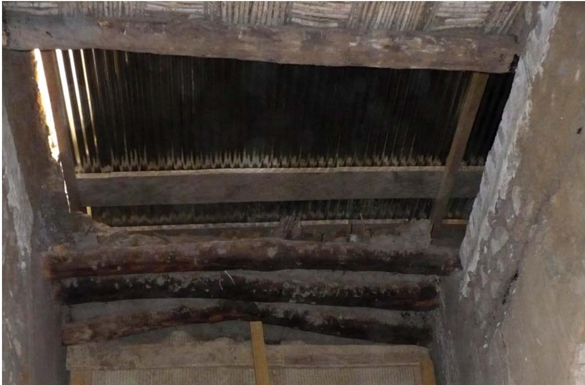
*Reconstruction de la toiture avec un remplacement de près de 50% des poutres de rôniers défectueuses et un allègement*
