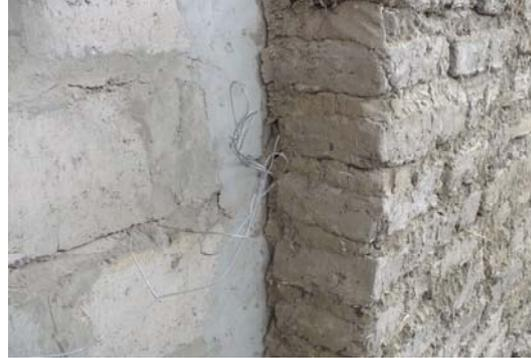
*Revêtement des structures en maçonnerie de parpaings par des briques d'adobe et un renforcement métallique*
