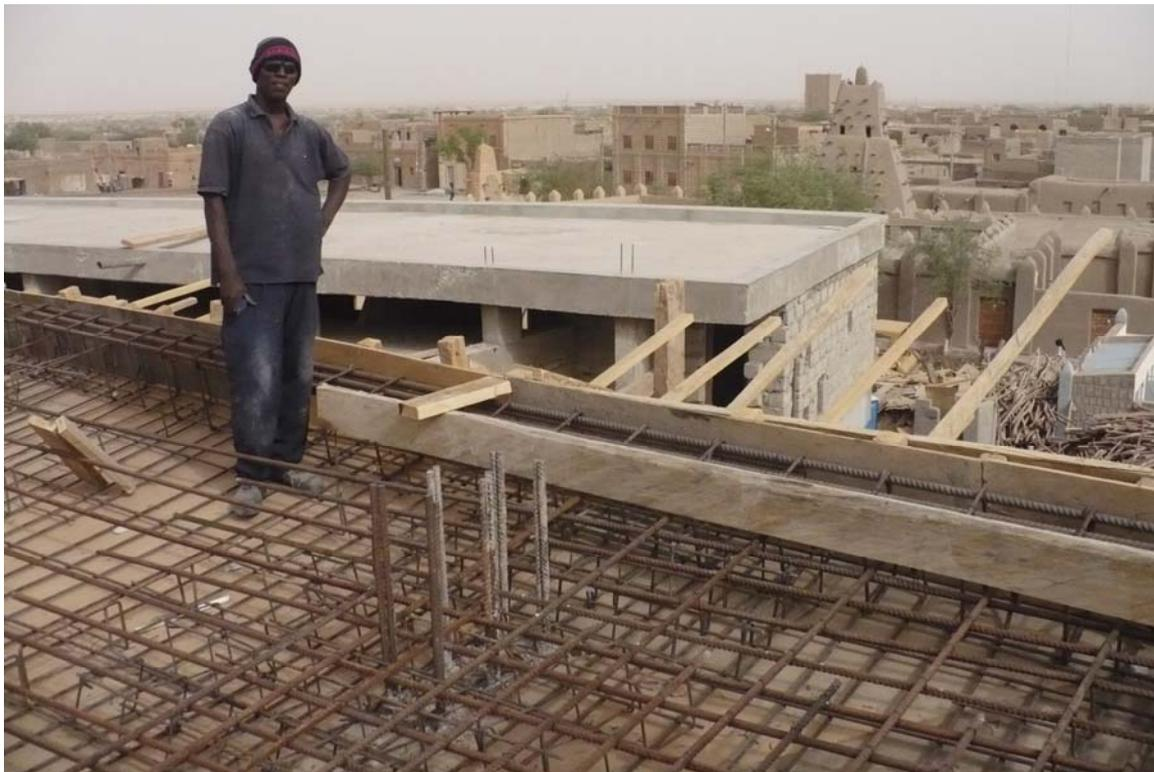
*Réalisation de la toiture du Centre en béton armé*
