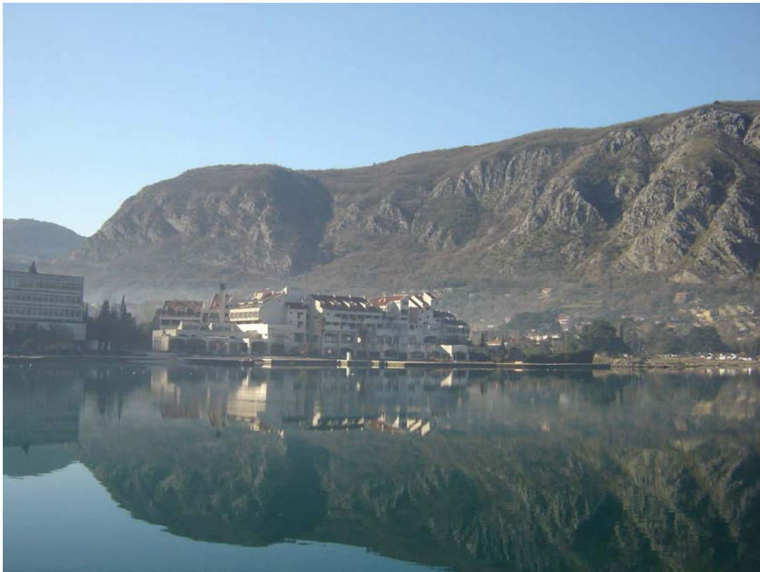
Photo 15 - Le cas de l'hôtel Fjord. Vue sur l'actuel hôtel Fjord. Il est prévu de le raser et de construire à sa place un hôtel encore plus grand. L'Institut régional propose de restaurer l'espace vert tel qu'il existait au début du XX e s.
