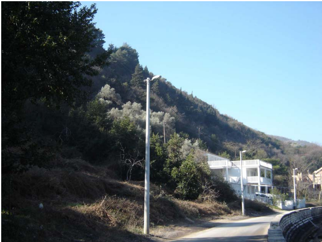
Photo 19 - Urbanisation dans la baie de Kotor – changement du profil vertical du paysage. Constructions sur le versant avec des oliviers près de Stoliv
