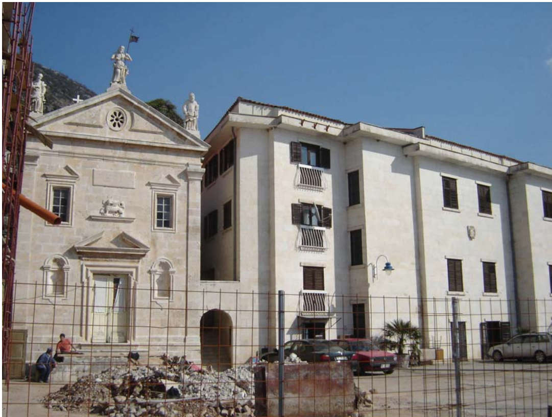
Photo 27 - Conservation urbanistique à Perast. Le bâtiment à droite doit être détruit et remplacé par un grand hôtel
