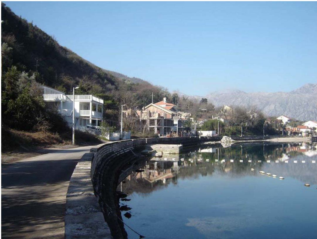
Photo 18 - Construction sur l'espace vert près de Stoliv, avec l'autorisation de la mairie
