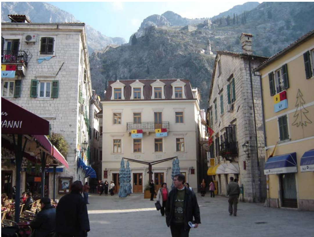
Photo 30 - Conservation et revalorisation de l'hôtel «Vardar» (Photo 30).
