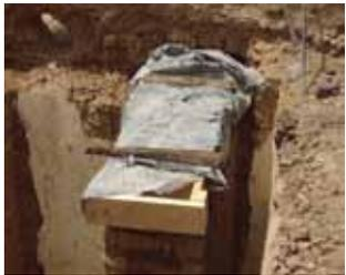
Le sommier est mis sous plastique pendant 4 jours pour «la cure humide» (afin de garantir la résistance maximale du béton)
