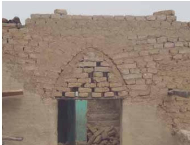
La forme de l'arc est déterminé par le coffrage.
