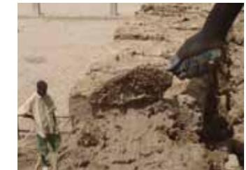
Le maçon fait remonter du mortier sur le côté de la brique qu'il vient de poser. Cela permet de remplir le joint vertical au moment de la pose de la brique suivante
