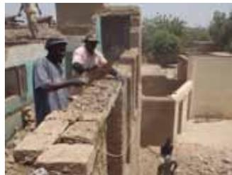
On bouche les espaces entre les roniers avec du mortier, puis on étale du banco sec pour limiter l'accroche sur les briques
