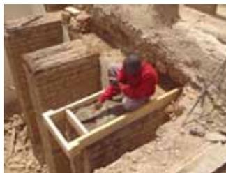
Le maçon coule dans le coffrage la première couche de béton du sommier où viendra se positionner le premier ferrillage
