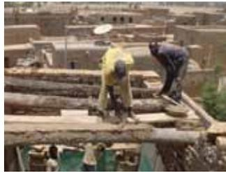
Le maçon recouvre les poutres de banco pour niveller en vue de la pose des lattes
