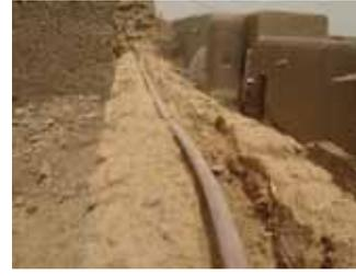
Si la qualité de la brique le permet, l'électricien peut aussi protéger la gaine en creusant une saignée dans l'arase du mur
