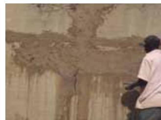
Reboucher avec du mortier et des morceaux de briques
