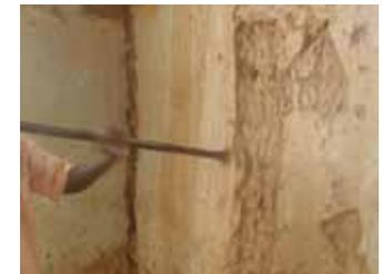
Détérioration importante de l'enduit existant à réparer: faire un curage, bien mouiller et poser l'enduit
