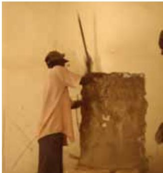
Décroquer la peinture et l'enduit, nettoyer à brosse humide pour permettre au mortier de coller
