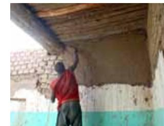
Lors de son élévation un côté du mur est toujours plus négligé que l'autre, le maçon fait donc un ragréage au mortier de terre avant l'enduit de finition
