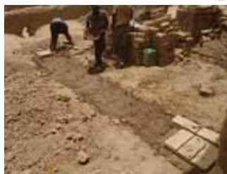
Sur un lit de mortier, on tire un cordeau et on commence à maçonner les fondations
