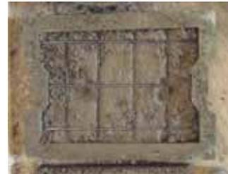
Insérer le ferraillage et bien le remuer pour le faire pénétrer dans le béton
