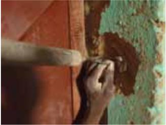
Quand la porte est à sa place, que tous les niveaux sont bons, on scelle la menuiserie à l'aide d'un fer plat, préalablement placé par le menuisier, que l'on cloue
