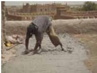
Finition à la main en travaillant en bande de 1m50 environ et en respectant une extrême régularité dans ses gestes
