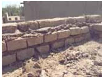
Appareillage de deux rangs de briques à l'aplomb de la façade
