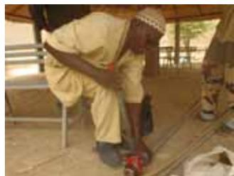
Le plombier découpe les tuyaux et dessine les pas de vis à l'aide d'une filleteuse
