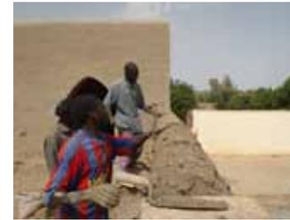
Finition d'un acrotère simple, avec une brique en longueur et la création d'un arrondi avec du mortier
