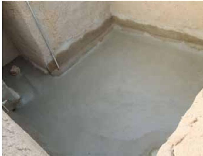
La chape ciment doit permettre une évacuation rapide de l'eau. A cette phase les pentes doivent être parfaitement exécutées. Ceci est réalisé au préalable avec un mortier de terre, ce qui permet aussi d'assurer une épaisseur constante de la chape et donc de minimiser les risques de fissuration.
