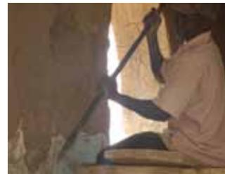
Mauvaise planimétrie du mur qui doit être nivelée à la pique et à la daba
