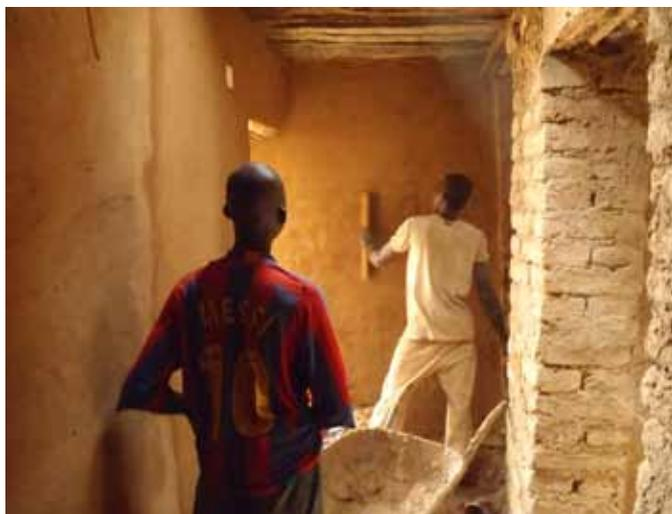
La pose de l'enduit intérieur est un travail minutieux. A djenné il est fait avec un mortier de terre/sable.
