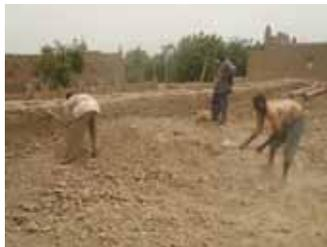
On dépose ensuite une épaisseur de 25cm de terre concassée sèche
