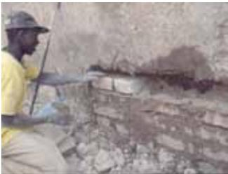
Le découpage initial du mur permet une jonction efficace entre l'existant et la réparation
