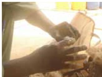
Pour connecter les tuyaux et les coudes entre eux, il entoure le pas de vis de fibre qu'il badigeonne de pâte à joint avant de visser
