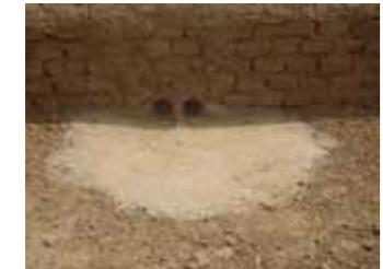
Le maçon creuse l'emplacement de la gargouille
