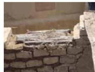
Les sommiers sont réalisés en ronier posés sur toute la largeur du mur et scellés au mortier de terre. (chaînage)
