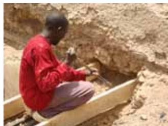
Positionnement et réajustement du coffrage
