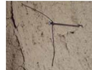
Système de maintien de la gaine dans la saignée: un clou auquel on accroche un fil de fer
