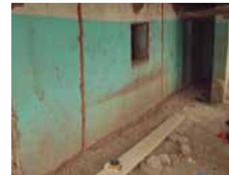
On bouche au mortier de terre les saignées de l'électricien. Le mortier devra être légèrement en retrait pour admettre l'épaisseur de l'enduit de finition
