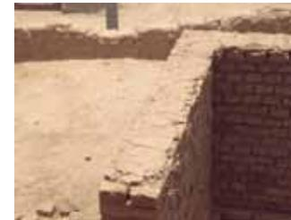
En attendant la toiture le maçon nivelle l'arase du mur avec du mortier
