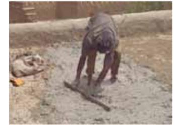
Le maçon étale le crépissage à l'aide d'une règle. Epaisseur de la 1ere couche: 6cm
