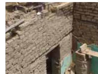
Préparation des sommiers du linteau à réaliser (nivellement des supports). Le maçon présente ensuite les bois de ronier
