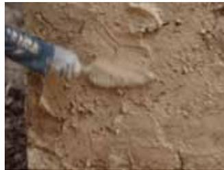
Pour retrouver la linéarité avec l'existant, on enduit après quelques jours de séchage et de tassement la nouvelle base de mur
