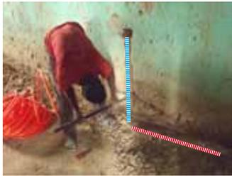
A l'aide de la pique, l'électricien creuse les saignées (5cm de profondeur maximum)
