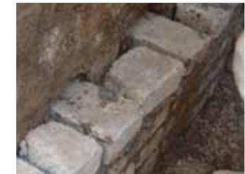
Curage des bases de mur. Le curage doit permettre d'introduire une brique dans sa longueur
