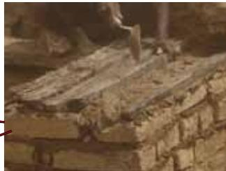
Détails des accroches en ronier (pénétration de 40cm dans le mur)
