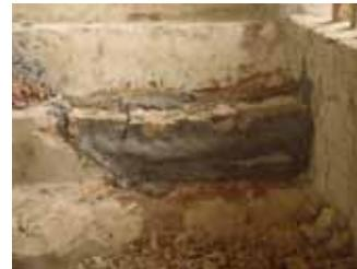
Reconstruction de la marche avec des briques scellées au mortier de terre
