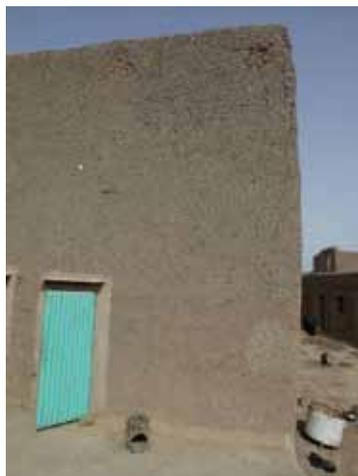
Angle nord est et façade est (fissure / érosion de l'enduit)
