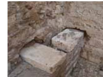
Insertion des briques d'ancrage.
