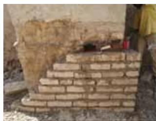
Maçonnerie en escalier, en attente pour la dernière section de mur
