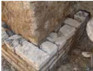
Détail de l'assise et des briques d'ancrage
