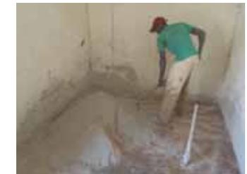
Déplacer à nouveau le mélange d'un côté puis de l'autre jusqu'à ce que le mélange soit homogène
