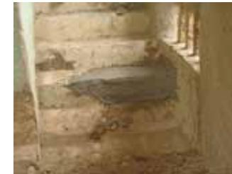
Finition au mortier de terre avec lissage à la truelle
