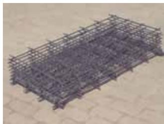
Préfabrication des ferrillages en fer de 10mm
