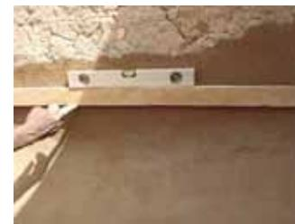
Préparation à la coupe du surplus de l'enduit. Le maçon vérifie avec la règle en bois et le niveau
