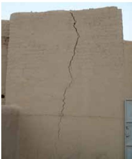
La fissure traversante au niveau des toilette ouest des Cases de passage était due à un tassement différentiel des fondations de la fosse des toilettes.
