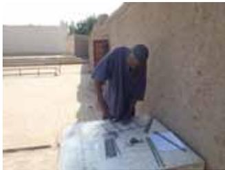
Après avoir coupé les fers à la longueur souhaitée, on assemble le ferrailage avec un fil de fer serré avec une tenaille
