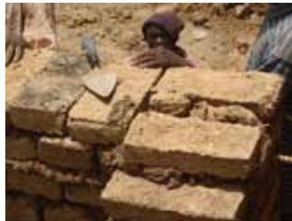
Détail de l'alternance des briques et du remplissage de l'espace entre les deux premières briques
