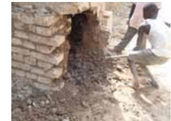
On creuse tout d'abord un trou au pieds de la colonne. On ouvre ensuite la colonne à l'endroit conçu à cet effet pour vider la fosse de ses déchets. Puis on rebouche le trou
