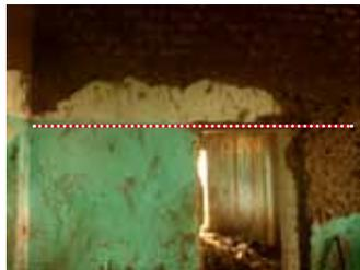
Couper la partie supérieure de l'enduit existant pour ne garder qu'un support propre et linéaire. Rechercher une planimétrie la plus parfaite possible
