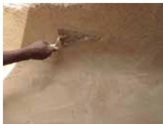
Les bases de mur sont arrondies pour permettre l'évacuation des eaux
