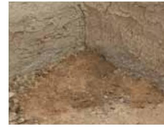
Les gaines sont recouvertes d'une forme de mortier de terre
