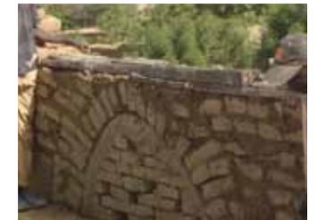
En plaçant un renforcement en ronier juste au dessus de l'arc, on augmente sa résistance et la répartition des charges
