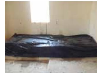
Stocker les briques sous plastique et les mouiller régulièrement pendant 6 jours pour permettre une prise optimale du ciment
