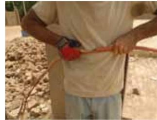
Faire entrer le fil électrique dans une gaine. Deux personnes se mettent aux deux extrémités de la gaine. L'une tire et l'autre pousse jusqu'à faire traverser le fil
