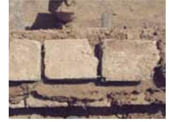
Le maçon vient ensuite protéger la gaine avec une rangée de briques posées au milieu du mur et scellées au mortier de terre (voir acrotère)
