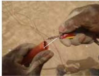
Faire entrer le fil électrique dans une gaine: utiliser le fil de fer se trouvant dans la gaine et bien l'accrocher au fil électrique
