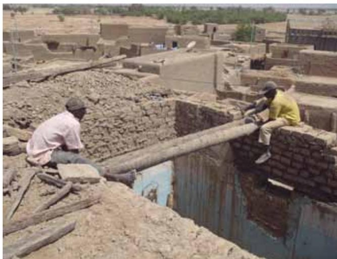
A Djenné, il existe plusieurs façons de mettre en oeuvre la structure des toits ce qui permet de s'adapter aux longueurs des poutres de ronier disponibles.
