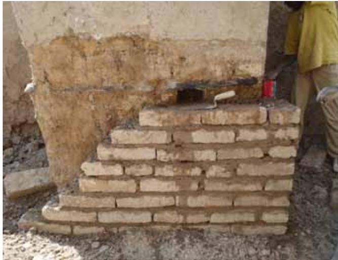
Quand la base des murs d'une colonne de toilette n'est pas trop endommagée, on décroute seulement 20cm de brique tout autour afin de reconstruire une enveloppe neuve qui résistera mieux à la saison des pluies.
