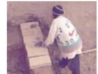
Pose de la première couche du chaînage dans une chaîne d'angle en bases de mur
