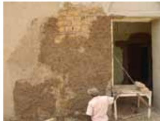
Le maçon projette fort le béton de terre sur l'arrête et la règle pour faire pénétrer le béton qui en séchant donnera l'épaisseur de l'enduit du jambage manquant
