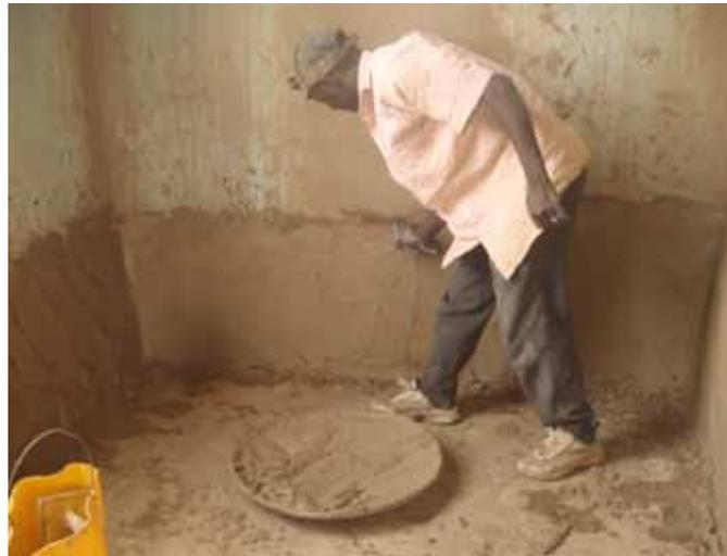
Durant les travaux, pour gagner du temps et limiter les transports, les maçons mélangent souvent le mortier de terre au pied du mur. Cette pratique endommage les bases de mur (eau et coup de daba).
