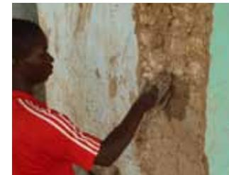
Scellement au mortier de terre/plâtre
