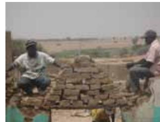
Fin du montage des briques posées à sec
