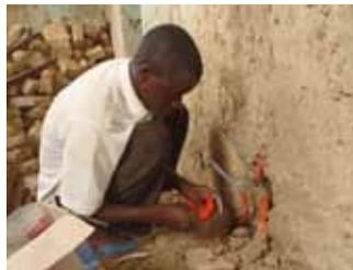
Détail du placement des boîtes de dérivation: l'électricien connecte les différents réseaux et place discrètement dans le mur la boîte de dérivation
