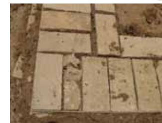
Détail de l'appareillage au niveau d'un angle
