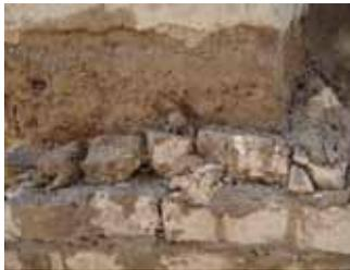
Détails de l'arase de la nouvelle base de mur. On charge de morceaux de brique pour limiter le retrait de la finition arrondie
