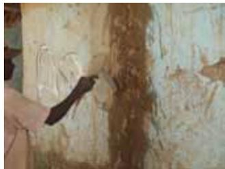
Le mortier de terre est ici déjà sec. A l'aide de la daba, le maçon cure les morceaux de terre gênants
