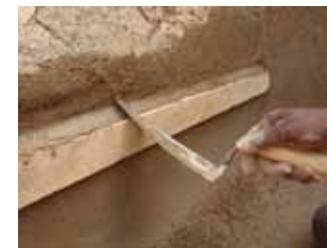
Coupe de l'enduit en biais pour optimiser le raccord entre l'enduit ciment et le futur enduit du mur
