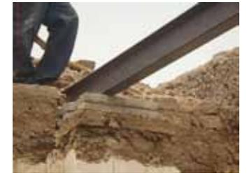
Alternative: 3 autres sommiers ont été réalisés à partir de 2 dalles de béton armé préfabriquées de 6cm (réutilisation des moules des dallettes du canal d'assainissement) / 69
