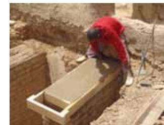
Le maçon finit de couler le sommier et lisse un minimum son béton de ciment pour ne pas faire remonter l'eau à la surface
