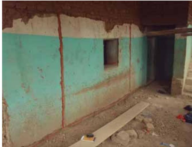
A Djenné l'électricien ne rebouche pas les saignées qu'il a ouvertes dans le mur. C'est le travail de l'artisan maçon.
