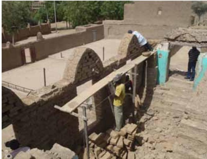
Pour réaliser un échaffaudage, on utilise la technique des trous de boulin.
