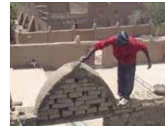
La forme du coffrage est finalisée avec du mortier de terre. Pour une forme parfaite on utilise un cordeau fixé en différents points du linteau provisoire
