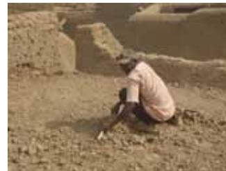
Le maçon nivelle la pente à l'aide d'une règle
