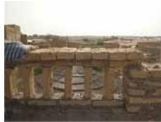
La dernière rangée de briques se pose dans le sens de la largeur
