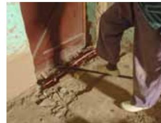
Le maçon règle le positionnement de la menuiserie. Ici il soulève à l'aide d'un levier le cadre de la porte
