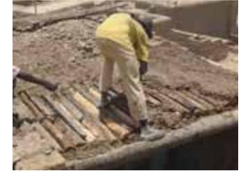
On recouvre le plancher de banco sur une épaisseur de 10cm
