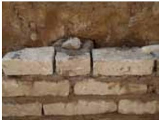
La brique d'ancrage est maintenue en place avec des morceaux de briques cassées
