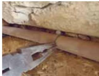
L'électricien maintient sa gaine au fond de la saignée à l'aide du fil de fer
