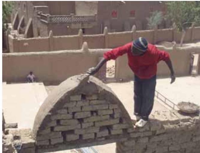
Dans un contexte local où le bois est rare et cher, le maçon a recours à un coffrage réalisé avec une maçonnerie de briques de terre crue posées à sec.
