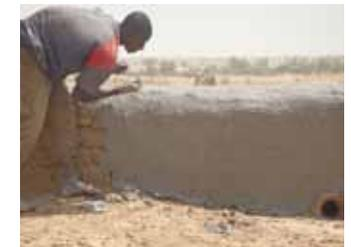
Une première couche d'enduit dite d'accroche est posée avant d'être recouvert par la couche d'enduit de l'ensemble du bâtiment
