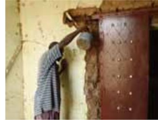
Le maçon cure et mouille les jambages afin de sceller définitivement la menuiserie
