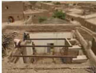
Après la mise en oeuvre des sommiers, les travaux de pose et de contrôle des poutres IPN sont les mêmes que pour des poutres en ronier. Ici l'entraxe est de 160cm
