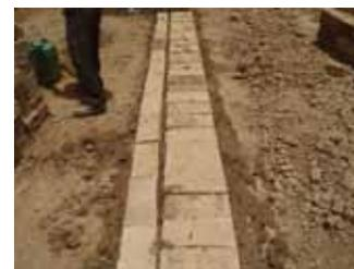
Détail de l'appareillage. Il suffit ensuite d'alterner l'appareillage pour obtenir une liaison parfaite entre les assises de briques
