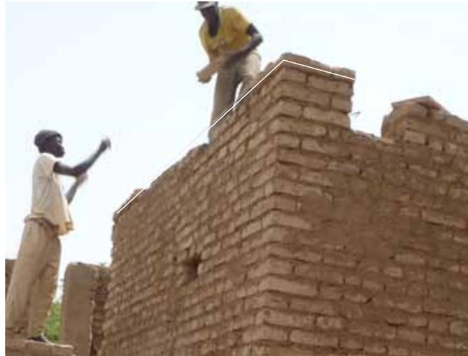
Cette étape élémentaire est la base du savoir faire d'un maçon. Pour le mur de 40cm d'épaisseur on pose les briques en boutisse. Elles sont réglées en utilisant le fil à plomb et un cordeau.
