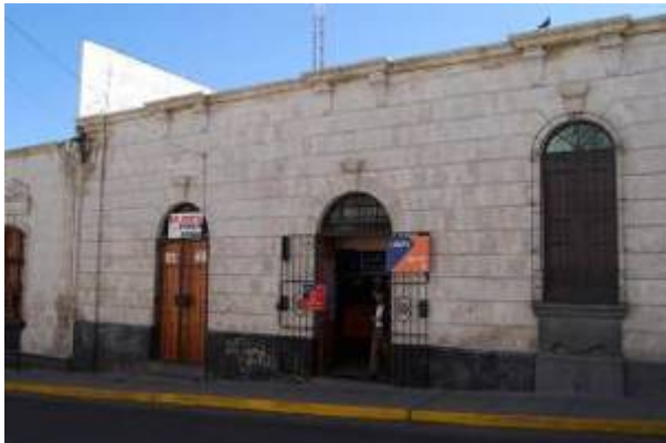
Fig. 2.8. Fachada del edificio vaciado
