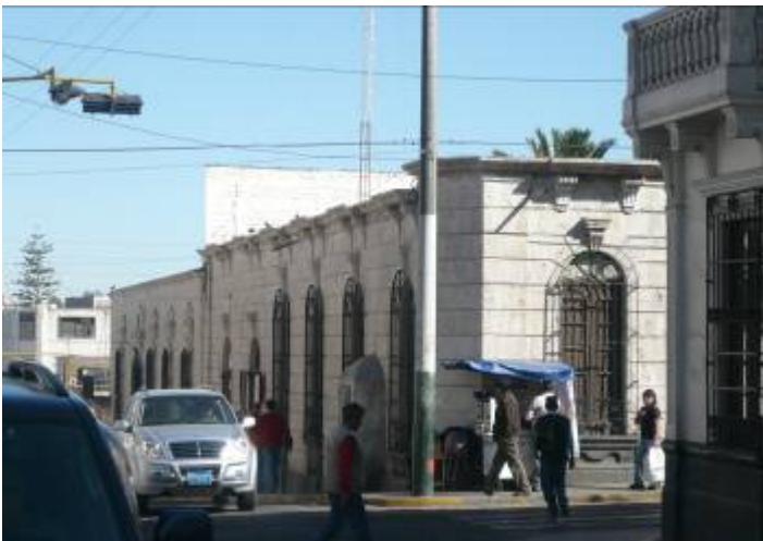
Demolición C/Bolívar-San Agustín
