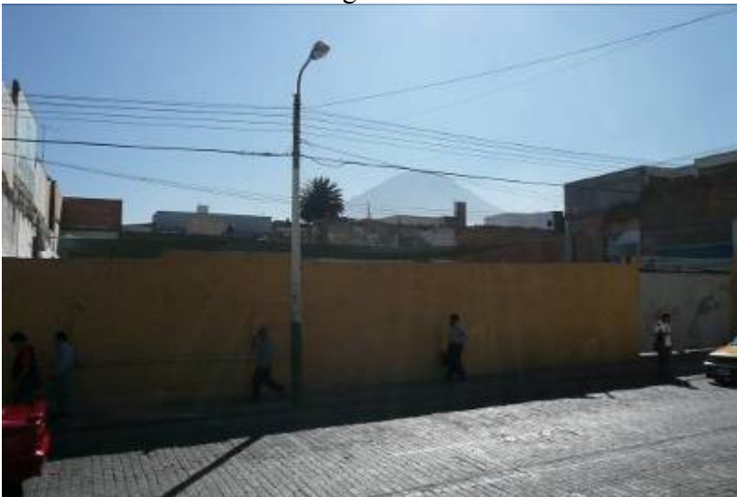
Demolición C/San José, 119-121-123
