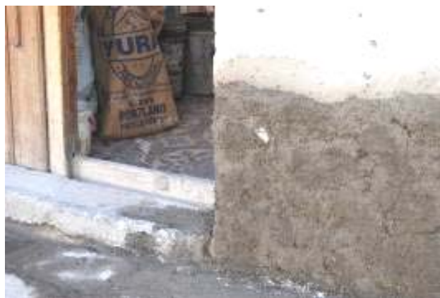
Fig. 2.16. Revoques de cemento
