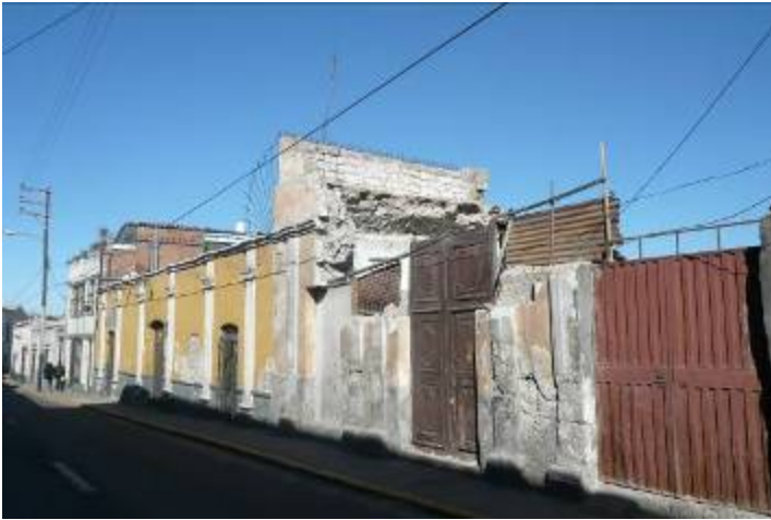
Demolición en 2008 C/ Villalba, 109.
