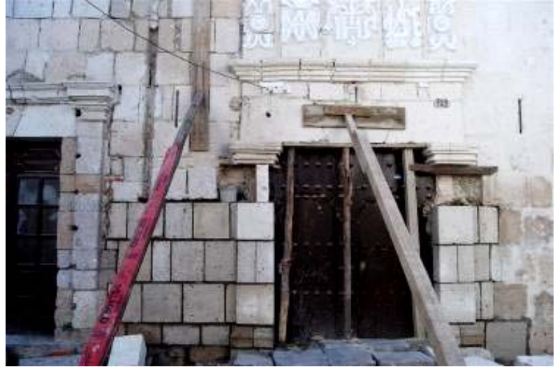
Fig. 2.22. Colocación de material nuevo asentado con cemento
