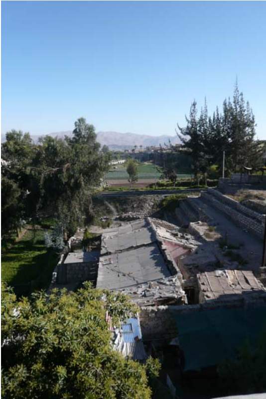
Presencia de la campiña en las proximidades inmediatas del núcleo urbano
