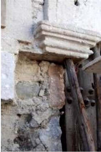
Fig. 2.21. Corte del sillar a de “amarre”
