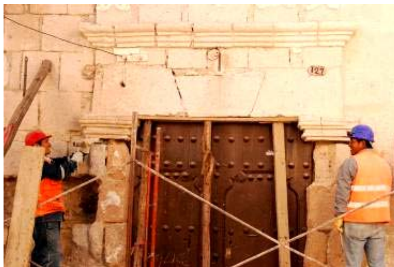
Fig. 2.20. Demolición de las jambas
