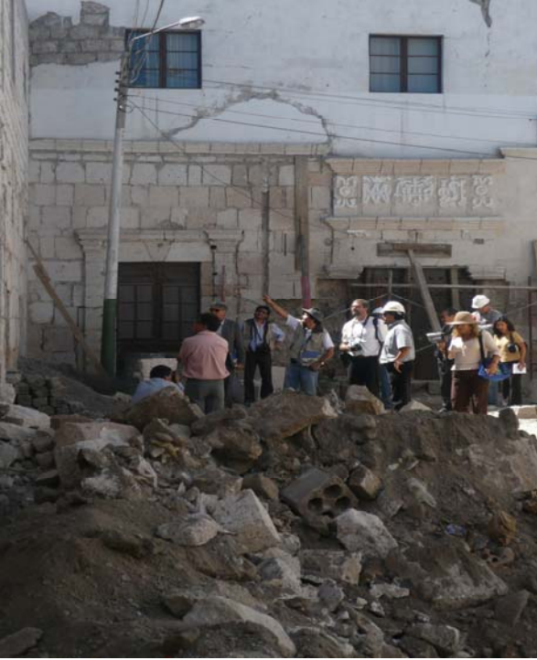
Visita técnica a las intervenciones en San Lázaro
