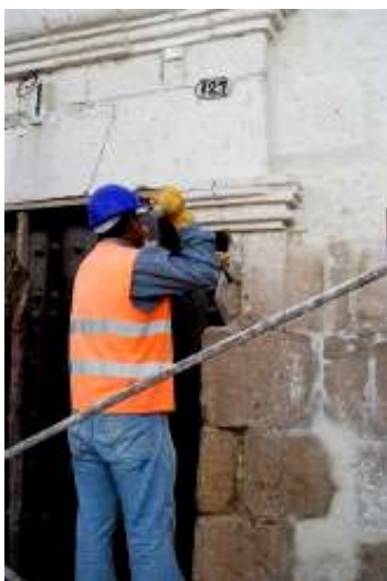
Fig. 2.19. Eliminación de sillares
