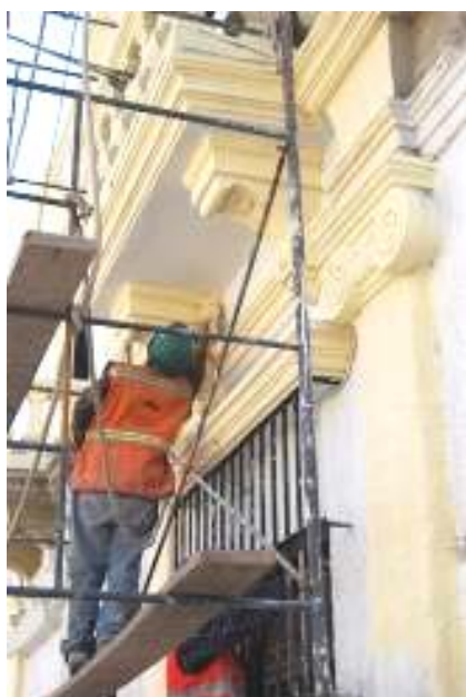
Fig. 2.17. Pintura con esmaltes vinílicos
