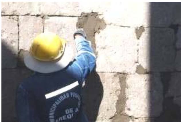
Fig. 2.15. Aplicación de morteros de cemento
