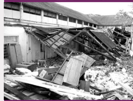
L'annexe de l'ancien Hôpital néerlandais de la vieille ville de Galle a été détruite par le raz-de-marée
