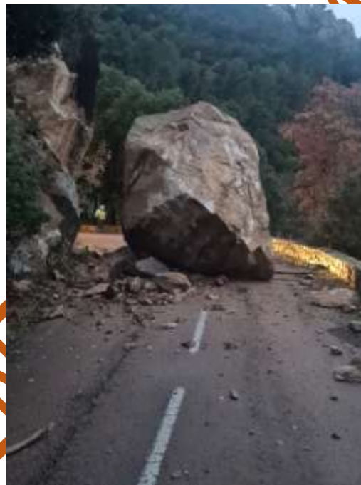
Figure 19 : Eboulement du 25/11/2021 entre Porto et Piana (Corse Net Infos)
