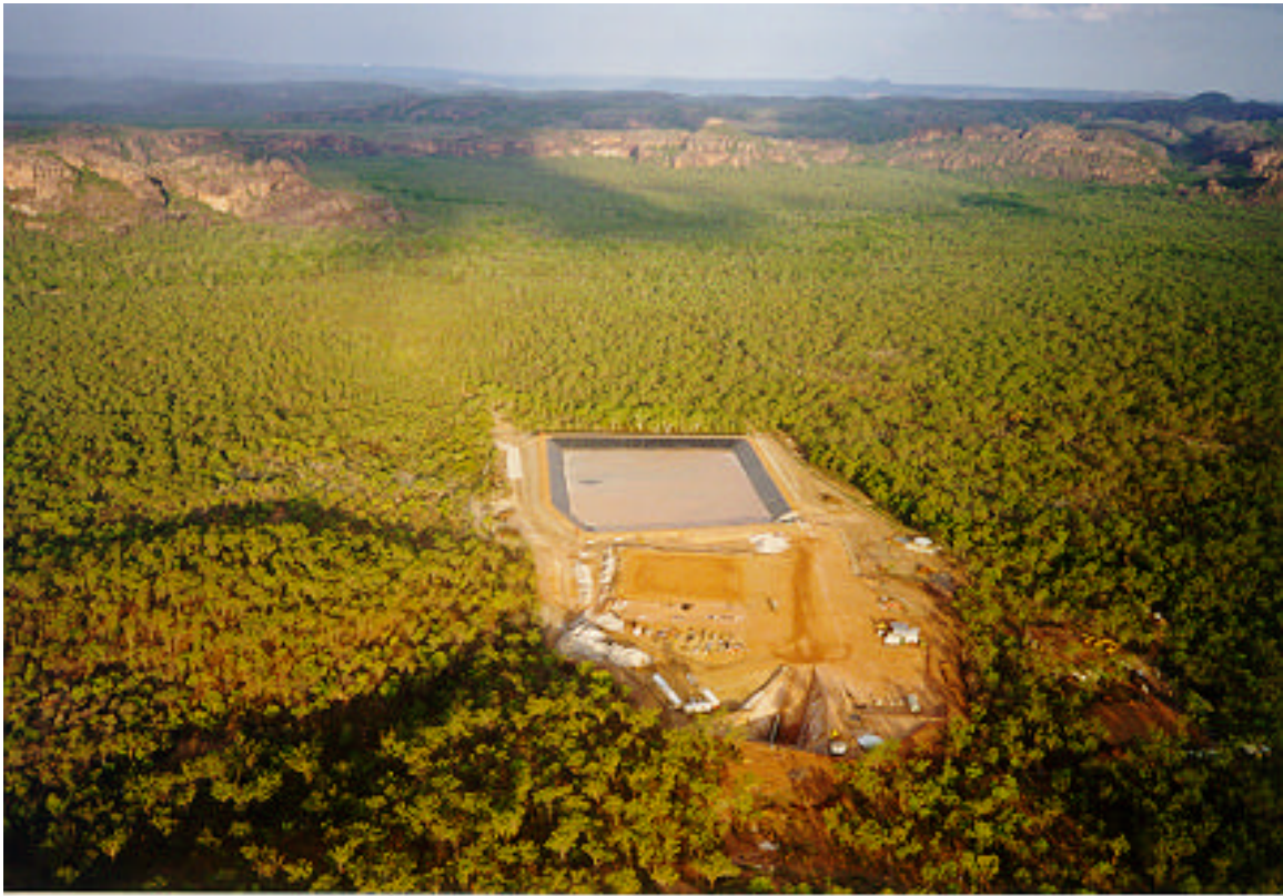
Photo 1 Vue aérienne montrant l'état de construction de la mine d'uranium dans la concession minière de Jabiluka en octobre 1998.
