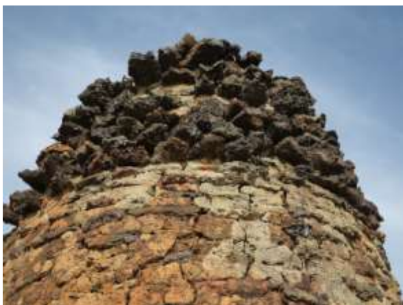
Planche photo 7: Vues rapprochées de l'un des fourneaux, montrant les détails de construction du tronc en terre avec par endroit des incrustations de fragments de tuyères, et au sommet des scories protégeant la partie la plus exposée du fourneau. Les images du bas mont
