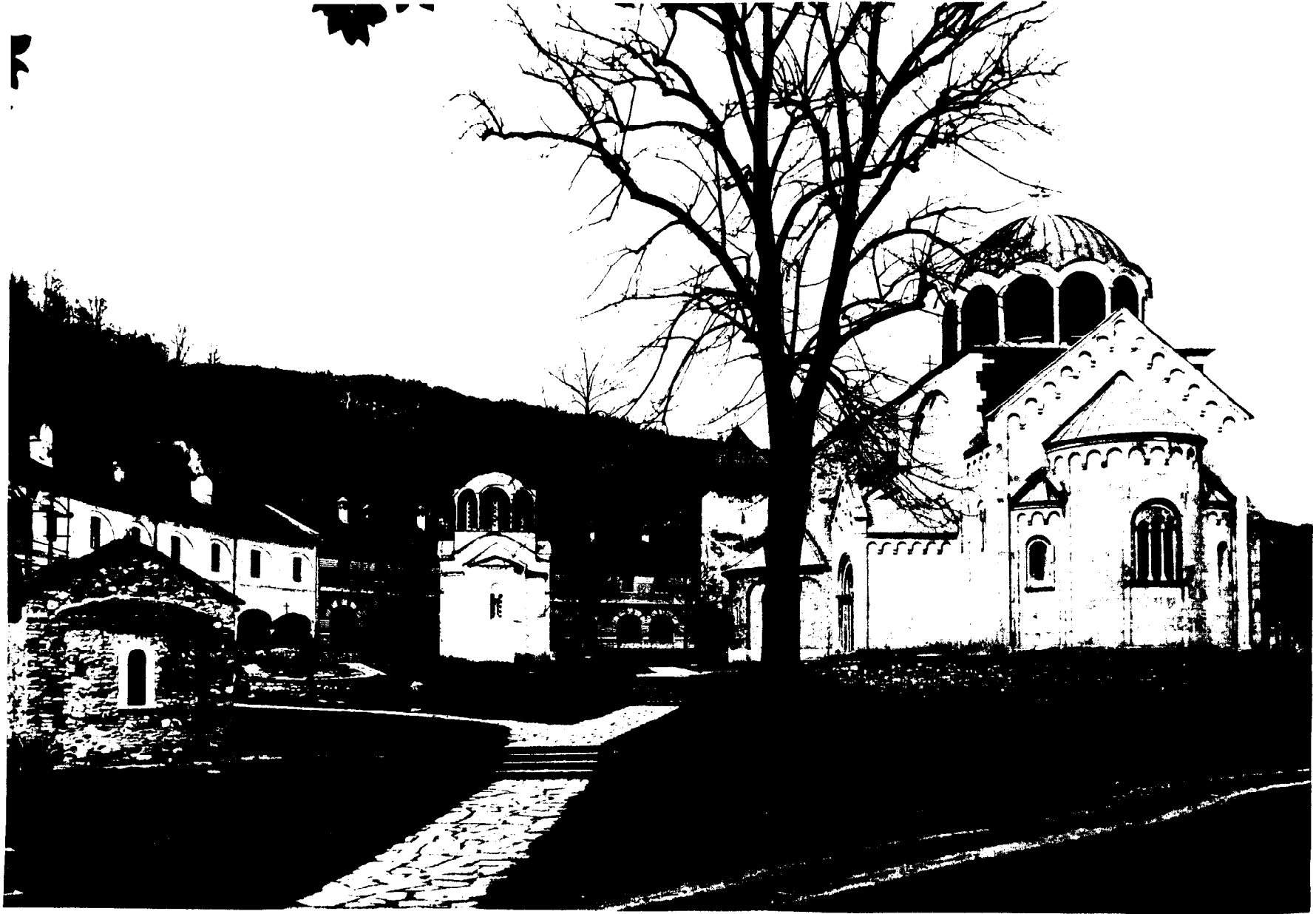
STUDENICA : St. Nicolas, Eglise du Roi et Eglise de la Vierge, vue du côté est (1983).
