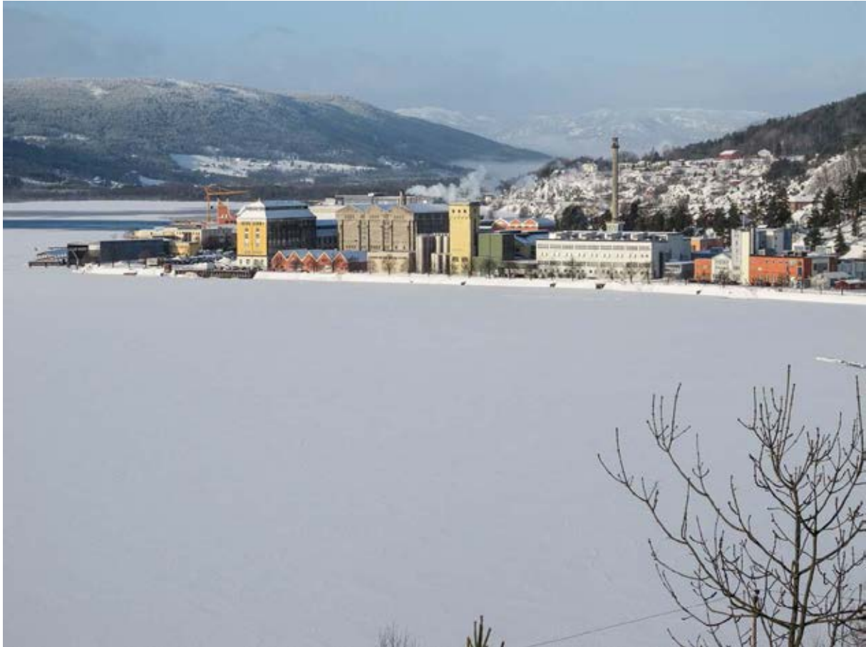
Parc hydro-industriel de Notodden
