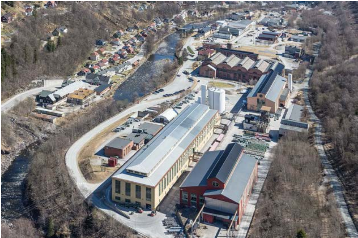
Parc hydro-industriel de Rjukan
