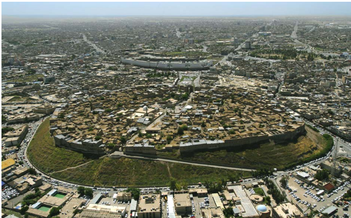
Vue aérienne de la citadelle
