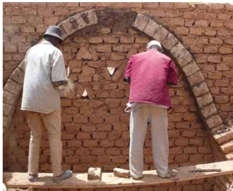
Figure 5 : Construction voûte MCB. © L. Cissé
