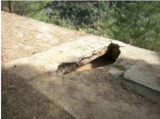
Dégradation de la dalle qui couvre le canal et sert de chaussée
