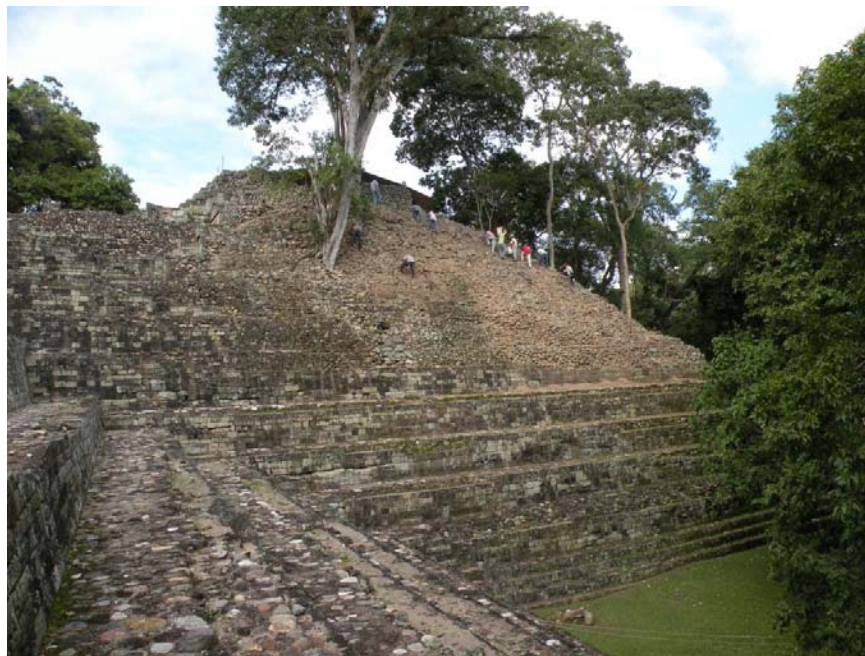
Consolidación de la Estr. 10L-26 en Proceso
