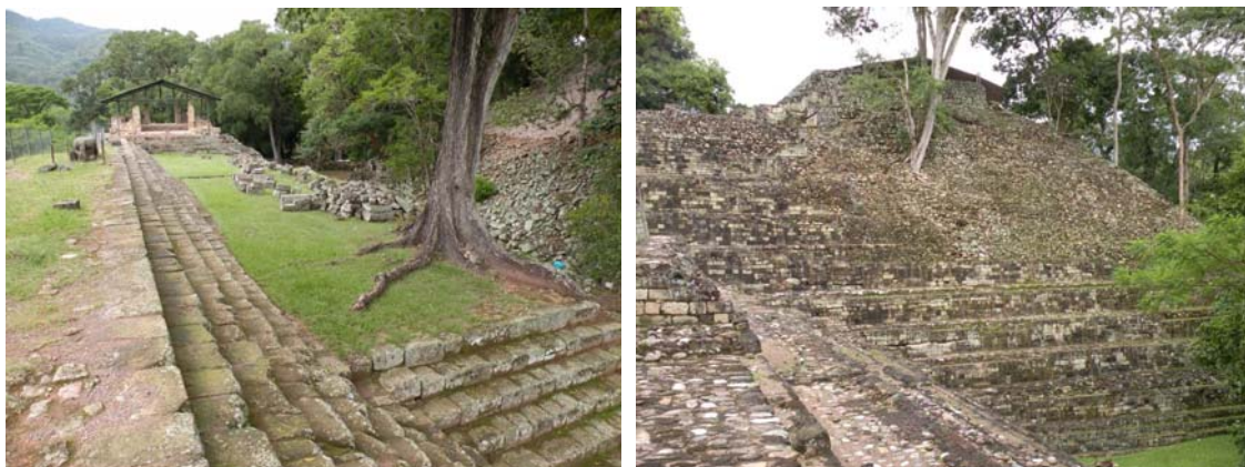
Las Estructuras 10L-17 (izquierda) y 10L-26 (derecha) antes de su Intervención
