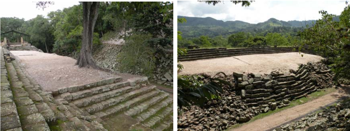
La Estructura 10L-17 al Final de su Intervención
