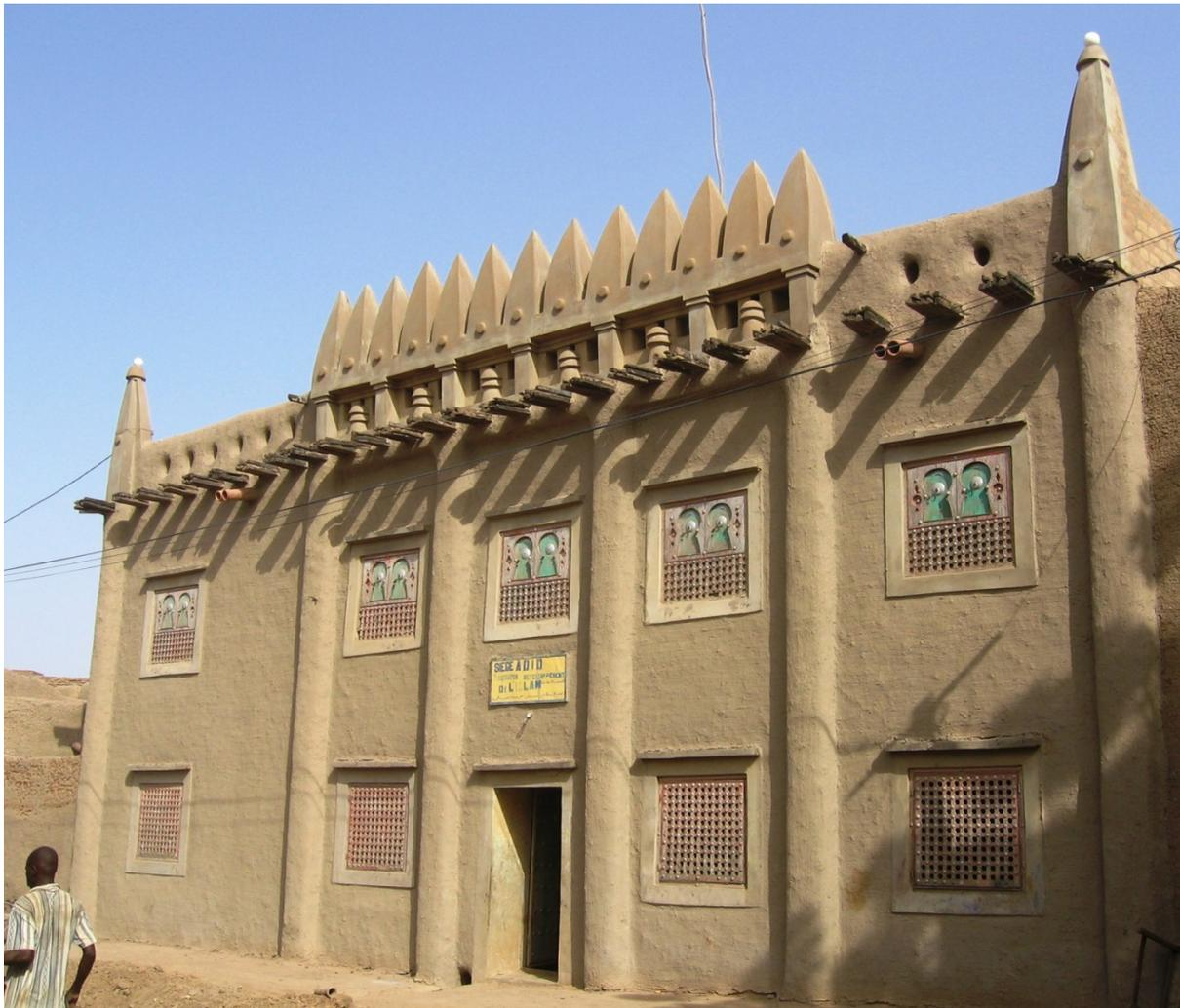
**Figure 27: Façade nouvellement crépie**
