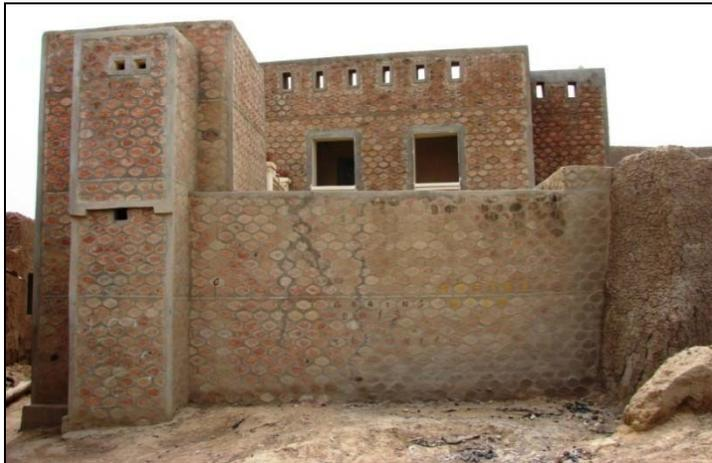
*Le bâtiment (figure) est entièrement revêtu en briques de terre cuite exposant le matériau terre en dessous à la perte de son élasticité et à la friabilité, ainsi qu'au pourrissement, la fonction de régulation thermique du matériau étant étouffée par les briques cuites peu poreuses.*
