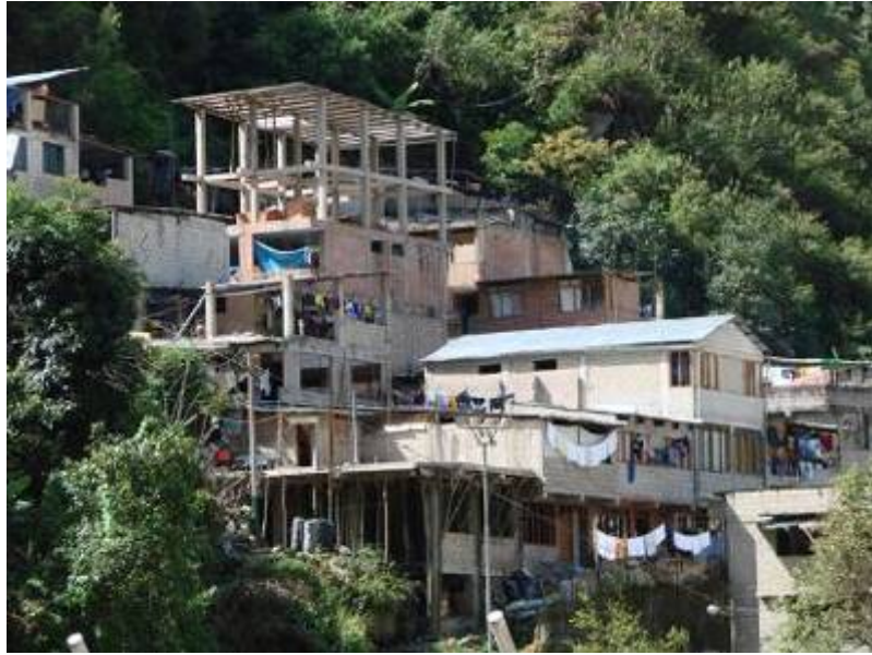
25. Crecimiento en taludes
